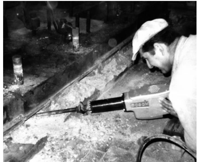
Bosch-Hammer für das Freilegen der Grundplatte
