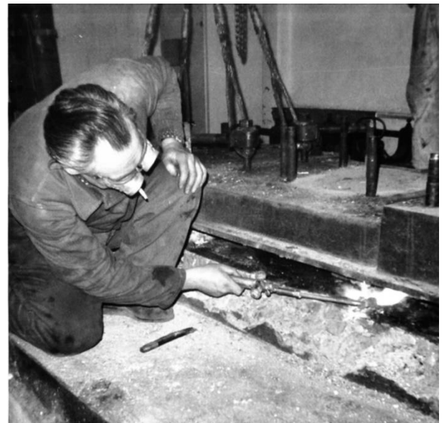
Abtrennen der Fundamentschrauben
