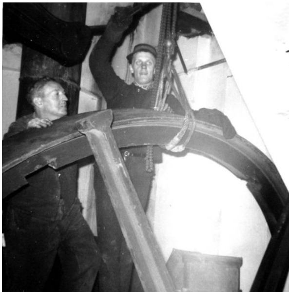
Demontage des Schwungrades
