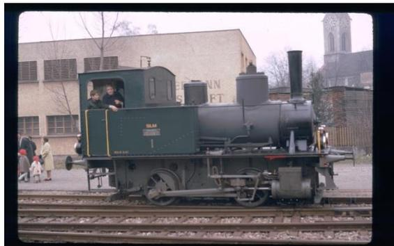
Die Schwesterlok unserer „Kleinen“ ist betriebsfähig in Brugg stationiert. Sie verfügt über Druckluftflaschen für Bremsung der Wagen. Auf Lok hat sie nur die Wurfhebelbremse, in Details ist sie anders als unsere Sulzerlok.
