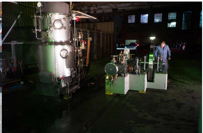
Um 17:45 war es bereits dunkel und es galt, aufzuräumen. Der letzte Akt war der Rücktransport der beiden Maschinen an ihrem Standplatz in der Halle. Herzlichen Dank an alle Kollegen! Ihr habt es möglich gemacht, die beiden Dampfmaschinen zu zügeln, in Betrieb zu nehmen und nach einem anstrengenden Tag wieder zurück ins Lager zu bringen. Die Besucher waren begeistert!
